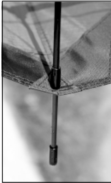
Sollte noch verbessert werden: Befestigung der 4 mm CFK-Stand-Offs im Segel.
